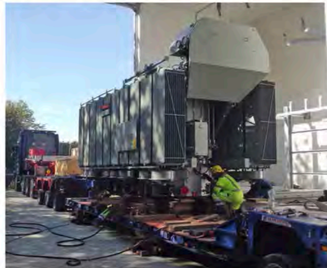
Bild oben: Anlieferung des Netztrafos.
