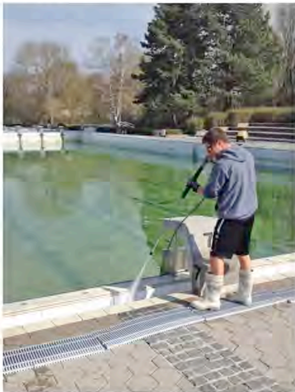
Bild: Unser Mitarbeiter Simon Thieme bei der Reinigung der Überlaufrinne des Sportbeckens.
