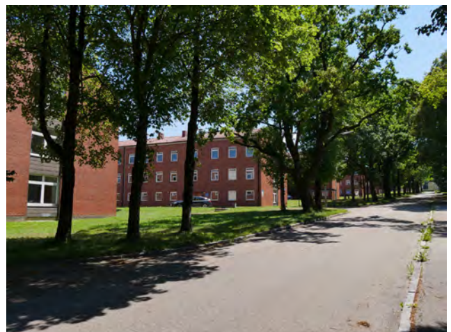
Mannschaftsunterkünfte - Gebäudenummern 130 bis 135
