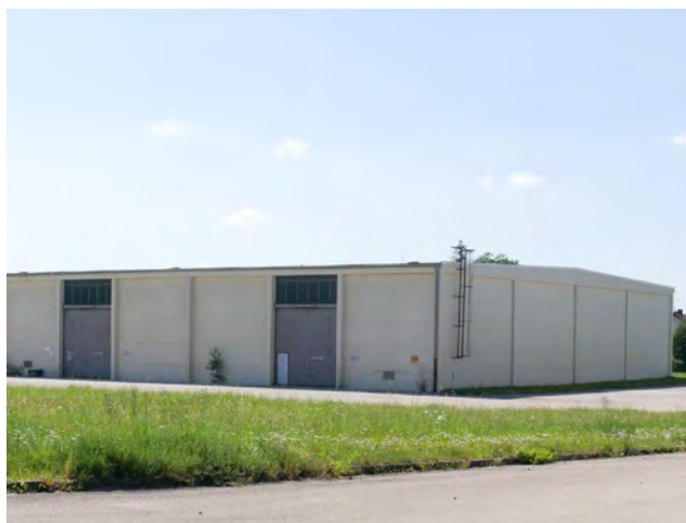
Hallen an der Westgrenze - Gebäudenummer 256, 258, 284
