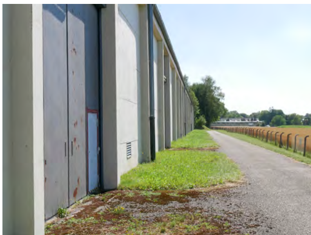
Hallen an der Westgrenze - Gebäudenummer 256, 258, 284
